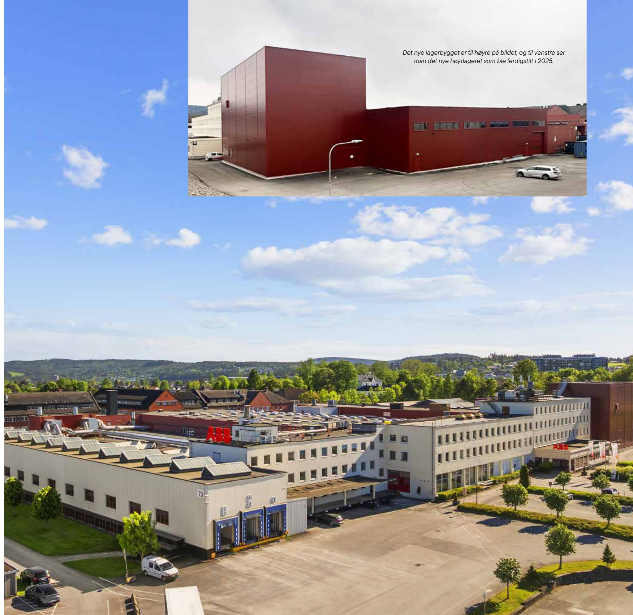
ABB (tidligere Sørlandske Elektriske AS) ble etablert i Skien i 1915. Virksomheten har vokst betydelig og er i dag Skiens største industribedrift med utvikling, produksjon og salg av energieffektive løsninger og anlegg for lav- og høyspenning. ABB er i dag en av Skiens største arbeidsplasser med ca. 900 ansatte.
